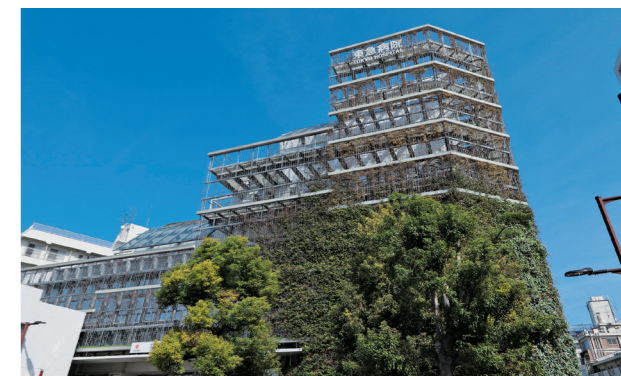
東急目黒線・大井町線 大岡山駅の駅上にある東急病院
