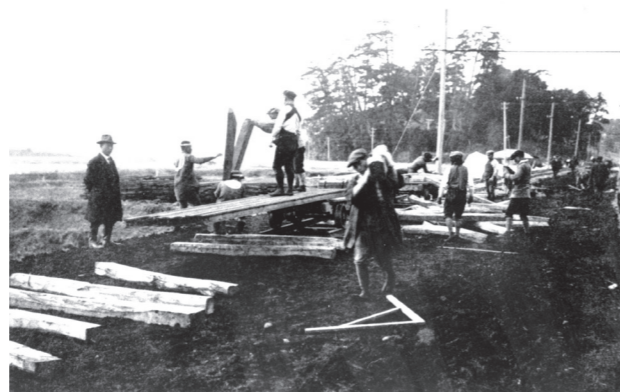
丸子(現:沼部)付近の目蒲線(目黒線)の建設現場
