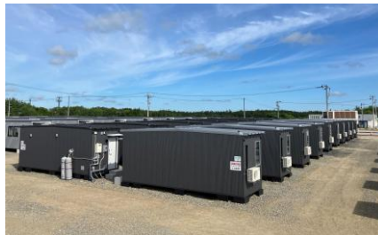
能登空港多目的広場に設置した復興支援者用宿舍
