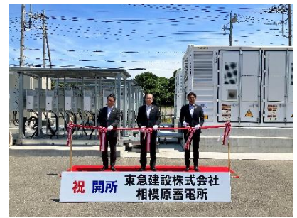
相模原蓄電所 開所式の様子
